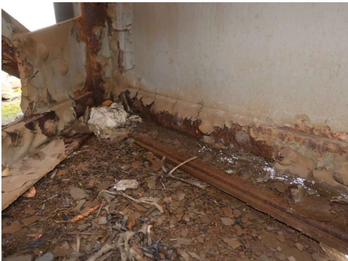
Obr. 29: Korozní solabení levého hlavního nosník nad P 01 [2-6]
