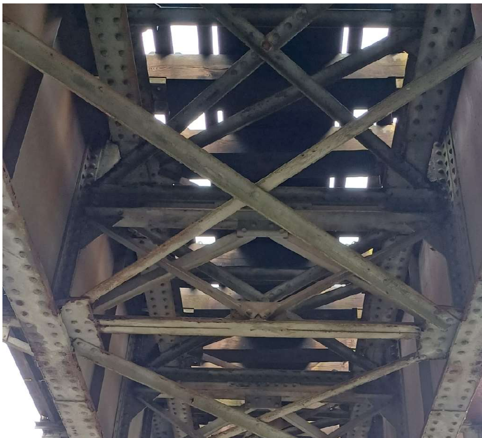
Obr. 10: Podhled na ztužení konstrukce K01
