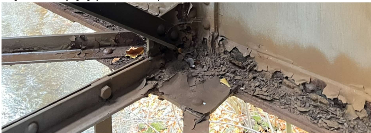
Obr. 63: Typický styčník na spodní pásnici
