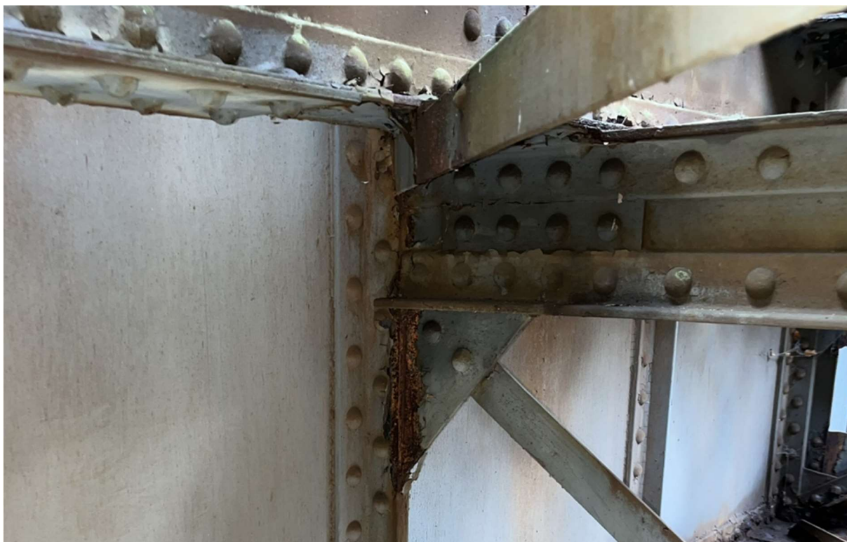
Obr. 66: Typický styčník na stěně hlavního nosníku
