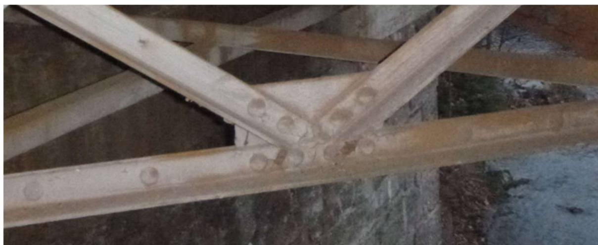
Obr. 72: Typický styčnick svislých diagonál na dolním příčnicku
