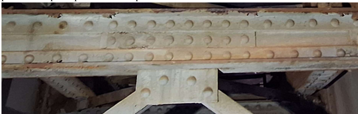
Obr. 69: Typický styčník svislých diagonál na horním příčníku
